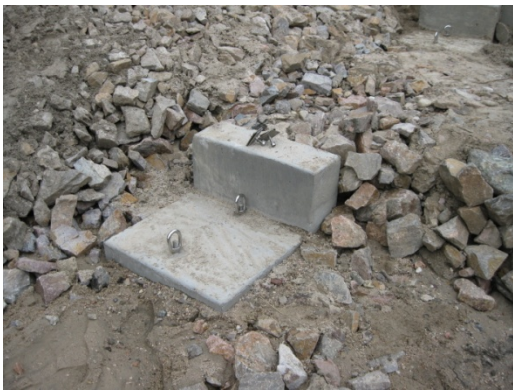
Photo 5: Form and Pour Concrete Anchor
